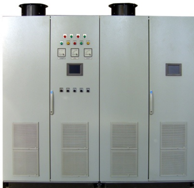
Рис. 1. Статическая система возбуждения со 100% резервом СТС-2П-160-1050 УХЛ4
